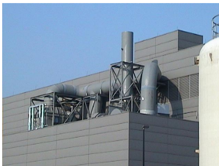
图 1-7 现有酸性废气洗涤塔
